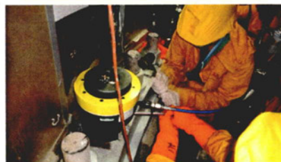
現場安裝及鎖緊度測試
