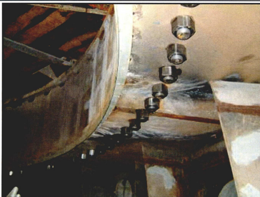
照片八 未去除之部分表面原鋅粉底漆(Primer)
