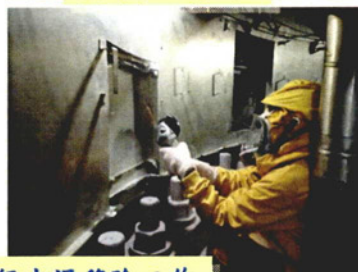
因應施工空間狹小，以蹲姿進行水泥移除工作
