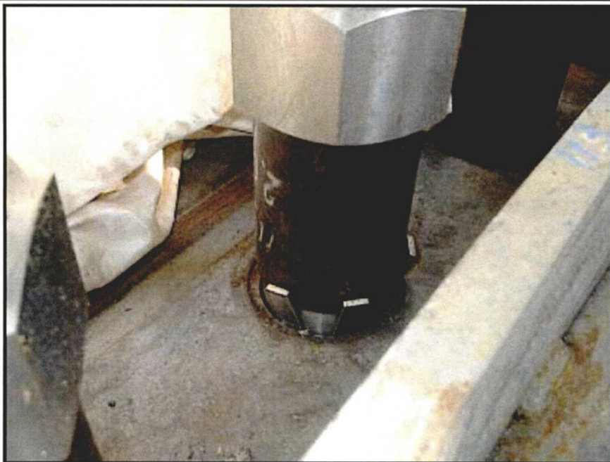
照片六 利用外加碳鋼片將地錨螺栓固定
