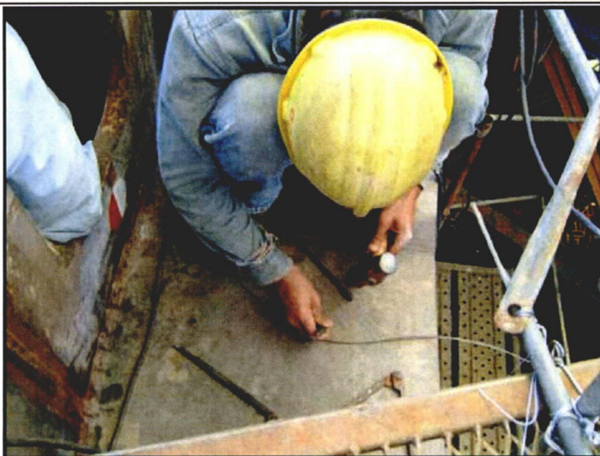
照片一 支撐托架孔洞中心點劃線後以中心銜定位
