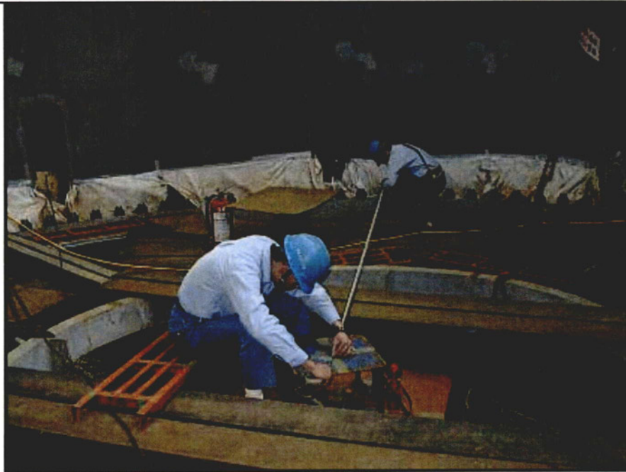
照片九 以校正過之鋼捲尺測量地錨螺栓中心點半徑
