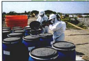
廠區廢棄物開挖封桶貯存
