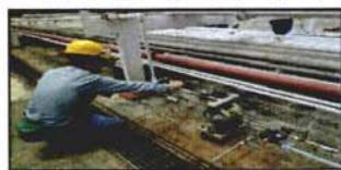
後勁溪東側高濃度地下水抽除
