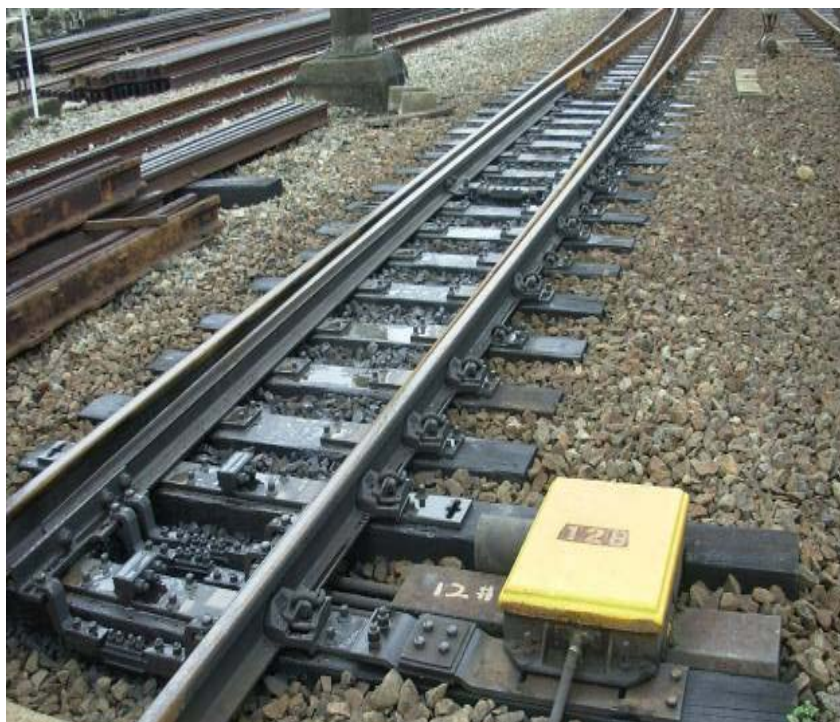
台鐵道岔結構
