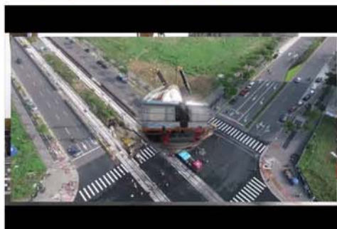
淡海輕軌列車安置軌道聯結作業
