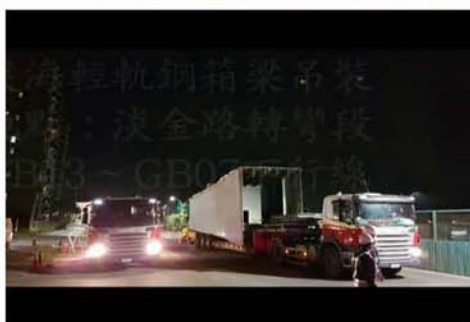
淡海輕軌鋼梁吊裝作業
