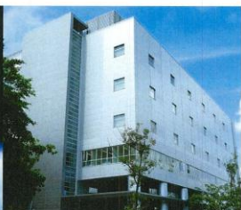
國家生技研究園區G棟 承諾動物福祉 環保永續建築
