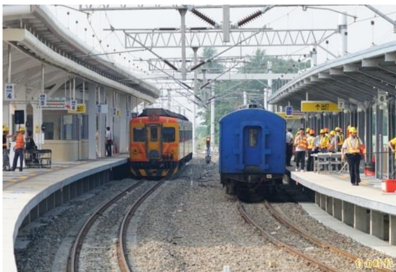
南迴鐵路電氣化計畫
