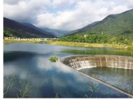
水銀行(補充地下水、治災防洪) 大潮州人工湖
